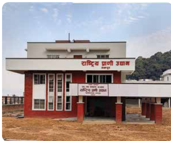
राष्ट्रिय प्राणी उद्यानको कार्यालय भवन
